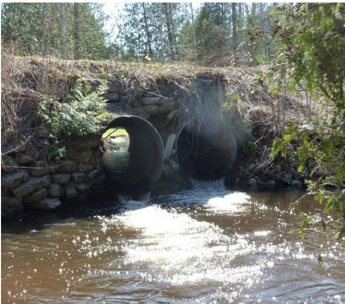
FOT. nr 17 i 18 – nieprawidłowo i prawidłowo zaplanowane przejścia przez potok (Źródło: http://nwrn.eu )
