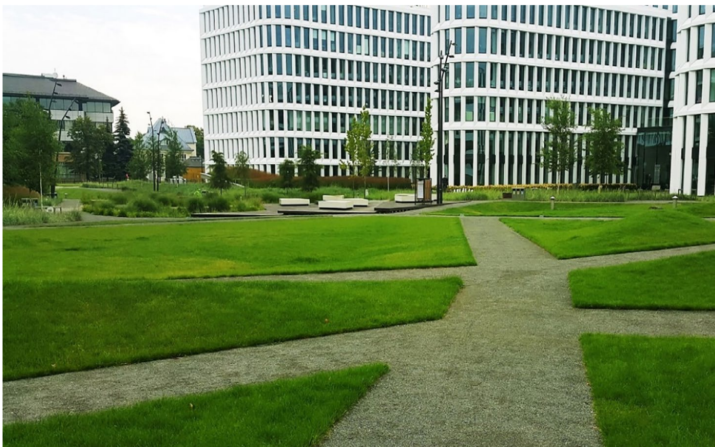
FOT. nr 50 – przykład zastosowania nawierzchni mineralno-żywiczej w przestrzeni miejskiej (Źródło: http://hanzaway.pl/ )
