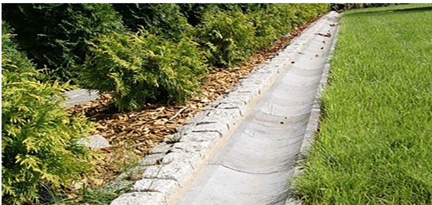
FOT. nr 24 - przykład zastosowania otwartego systemu kanalizacji deszczowej z wykorzystaniem korytka chodnikowego półokrągłego (Źródło: http://www.kostbet.com.pl/korytka-chodnikowe-polokragle_32_pl.html )
