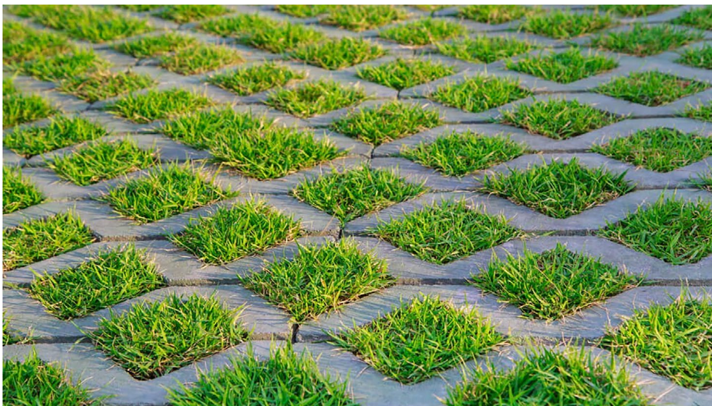
FOT. nr 45 - przykład zastosowania kostki ażurowej z wprowadzeniem roślinności trawiastej (Źródło: https://betto.pl/jak-ulozyc-podjazd-z-plyt-azurowych )
