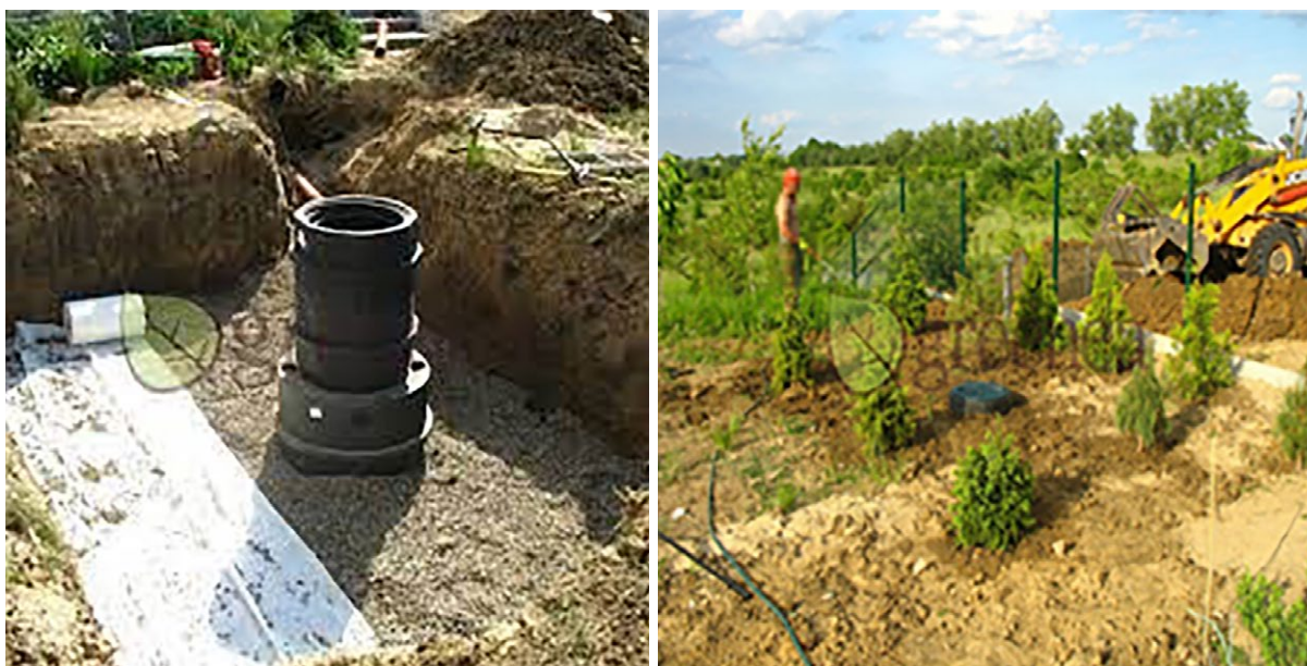
FOT. nr 37 i 38 - przykład zastosowania studni chłonnej (Źródło: https://www.greena.com.pl/studnia-chlonna-w-szczecinie )
