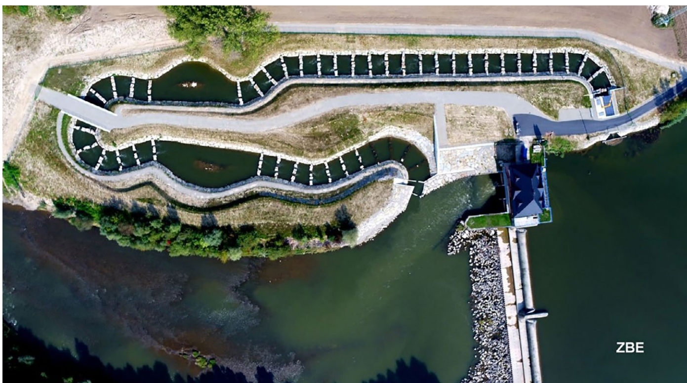
FOT. nr 22 – przepławka dla ryb w formie obejścia jazu na rzece Wisłoka w m. Mokrzec. Fot. ZBE (Źródło: https://www.wody.gov.pl/aktualnosci/2102-renaturyzacja-naturalne-materialy-i-przyjazne-srodowisku-rozwiazania-to-dzis-codziennosc-w-gospodarce-wodnej )
