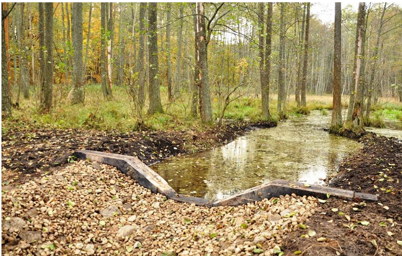
FOT. nr 13 – rów infiltracyjny z progiem piętrzącym
