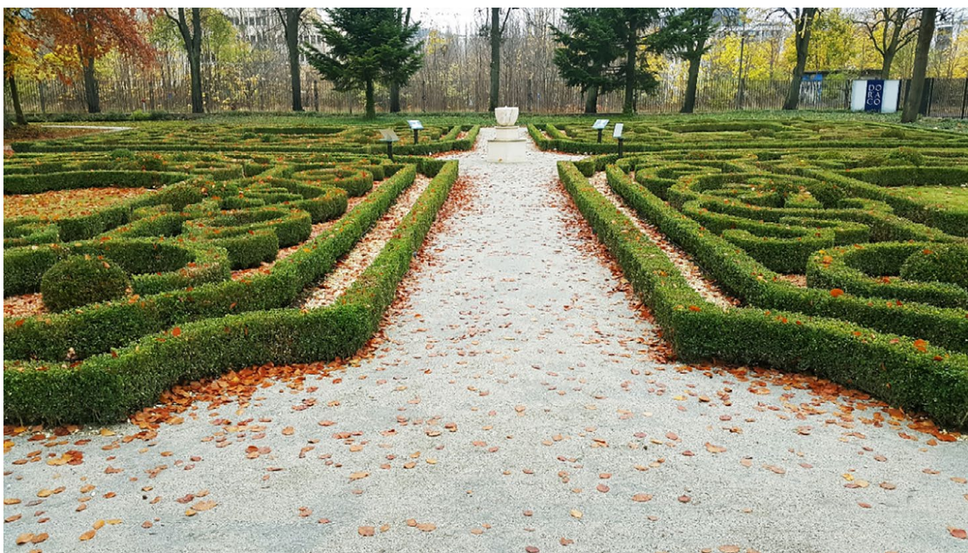
FOT. nr 49 – przykład zastosowania nawierzchni mineralno-żywiczej (Źródło: http://hanzaway.pl/ )
