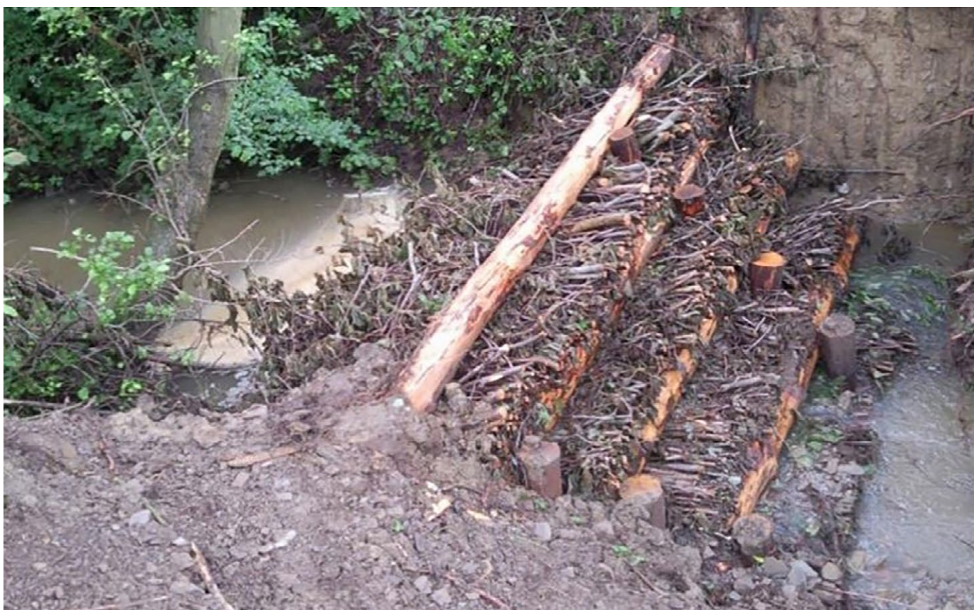
FOT. nr 19 – stawy wychytujące osady i spowalniające przepływ (Źródło: http://nwrn.eu )
